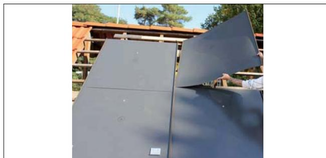
10. Far scorrere i n°2 profili di collegamento (7) per unire le lamiere centrali tra loro ed evitare che l'acqua possa filtrare tra le lamiere centrali. Fare in modo che il profilo superiore si sovrapponga a quello inferiore. Premere con una pinza in prossimità del profilo per farlo aderire meglio alle lamiere centrali.
