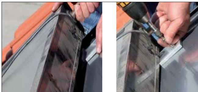
15. Posizionare le lamiera laterali inferiori destra e sinistra (1 e 3) accanto alla/e lamiera centrale/i (2). Applicare n°2 clip metalliche di fissaggio (9) con i relativi chiodi 2,5 x 25 (8) per ogni lamiera laterale (1 e 3) fissandole poi ai listelli. Inserire le lamiera laterali (4 e 6) facendole scivolare nelle lamiera laterali (1 e 3) e fissare le lamiera laterali (4 e 6) con una clip di fissaggio ciascuna.
