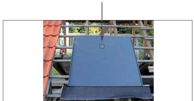
5. Posizionare le piastre di fissaggio inferiori (11) in corrispondenza del secondo listello (oppure a 18-23 cm dal bordo inferiore della lamiera inferiore). Le piastre di fissaggio inferiori (11) dovranno essere poi avvitate ad una distanza di 10 cm dal bordo destro e sinistro. Per prima cosa fissare entrambe le piastre inferiori con una vite  $\varnothing 5 \times 40$  ciascuna in dotazione, allineare con l'aiuto di una livella. Quindi inserire le altre viti.
