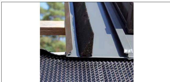
18. Applicare le strisce adesive (14) anche nella parte superiore, in modo che poi le tegole sormontino le strisce adesive. Fare attenzione in prossimità dei profili di collegamento (7) in modo che le strisce adesive si adeguino ai profili (7).
