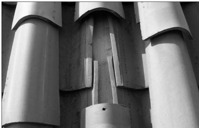
Fissare la piastra di giunzione in corrispondenza del travetto in legno che sorregge i coppi inferiori. Per ogni piastra di giunzione, marcare due punti di fissaggio sul travetto in legno e forare con punta per legno da 6 mm. Fissare ciascuna piastra di giunzione con due viti per legno e due rondelle. La profondità di penetrazione delle viti nel legno deve essere di almeno 40 mm.
