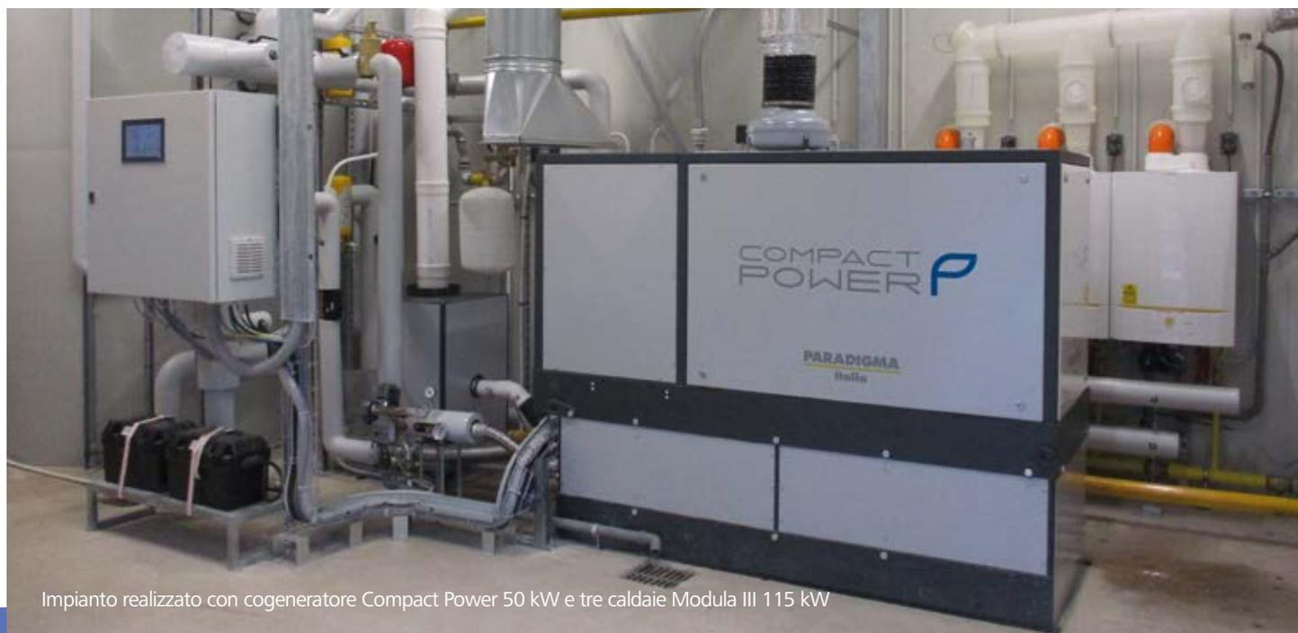
Impianto realizzato con cogeneratore Compact Power 50 kW e tre caldaie Modula III 115 kW
